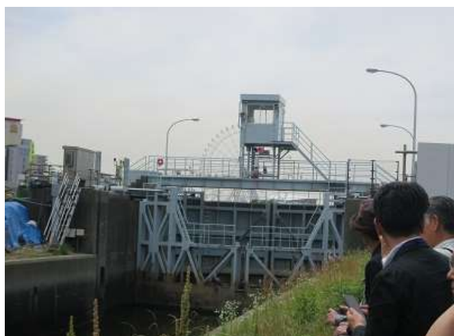
中川運河 中川口閘門 (海側) 海側の水門を開き、海側水位に調整
