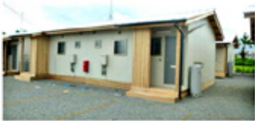
熊本広域大水害における木造2階仮設住宅(阿蘇市)
