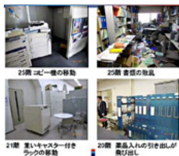
気象庁資料「東北地方太平洋沖地震における長周期地震動による揺れの実態に関する調査結果」より「工学院大学新宿キャンパスでの被害」。高層階(20~28階)でコピー機や重いキャスター付きラックが移動、書架からの書籍や書類の落下・散乱、薬品入れの引き出しの飛び出し、天井材の落下などの事象が起こった
