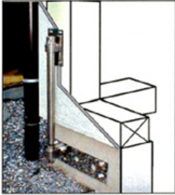
既存住宅の耐震補強技術「GDベースダウンアンカー工法」。建物外壁等を壊さずに外部から基礎と柱を接合する後付タイプのホールダウン金物を用いた工法。引抜き力の大きくかかる耐力壁に面した隅柱・通し柱を中心に施工する。解体・復旧がないため、短工期、低コストで済み、居住者の居ながら改修も可能(*2003年内閣府参考資料「耐震補強方法の例」より)
