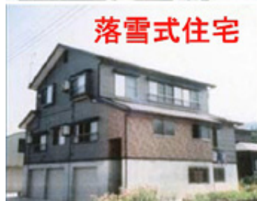
「大雪に対する防災力向上方策検討会提言(中間とりまとめ)」資料より、「克雪住宅」の例。上が融雪式住宅、下が落雪式住宅(高床式)
